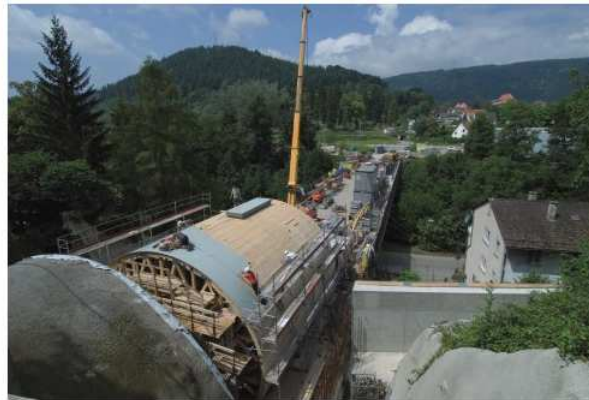
Montaż poszycia na samojezdnym szalunku systemu NOEtec.
