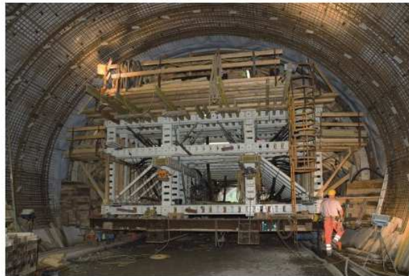
Szalunek samojezdny systemu NOEtec w pozycji betonowania.
